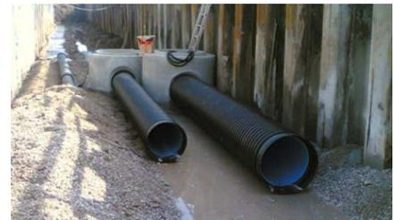
La funzionalità del sistema è garantita solo da un'azione sinergica dei tre elementi. Le palancole d'acciaio oltre ad avere particolari qualità meccaniche, dovrebbero essere trattate con diversi strati di protezione anticorrosiva contro l'aggressione dell'acqua di mare e dai prodotti inquinanti.
