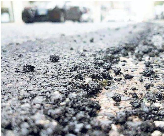
**Nell'immagine a sinistra lo stato in cui è stata ridotta via dei Salici a Marghera dopo la posa della fibra ottica. A destra un primo piano dell'asfalto in via Piave**
