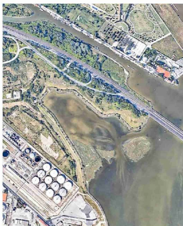
L'area dei Pili tra il parco serbatoi di Eni e il Ponte della Libertà
